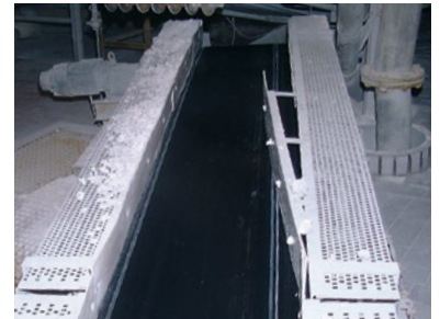
ContiClean® A-H im Einsatz zur Förderung von Titandioxid.
